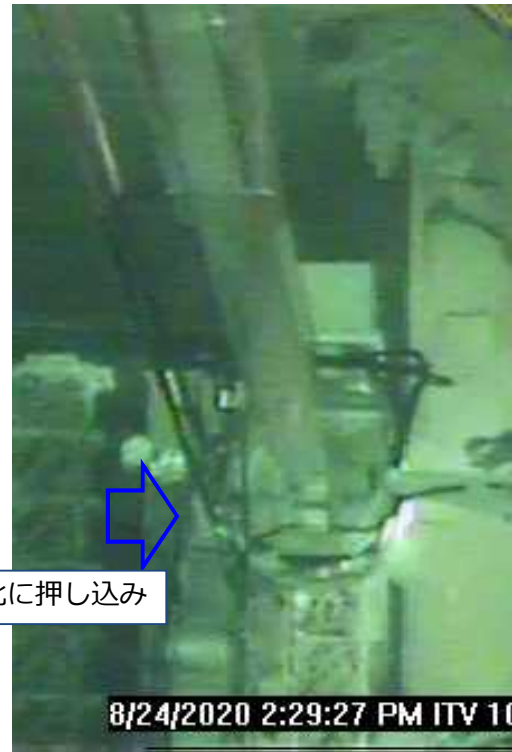
マニピュレータによるマストの補助 撮影日 2020/8/24
