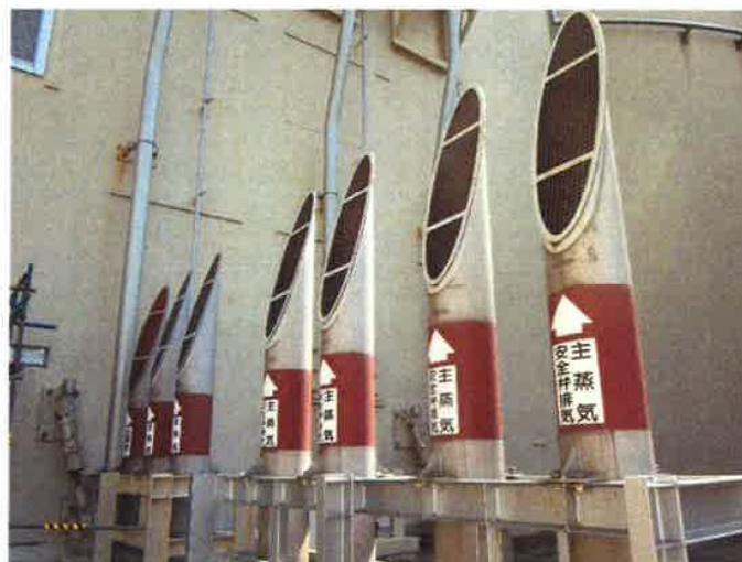
図3 主蒸気安全弁（排気管）の設置状況
