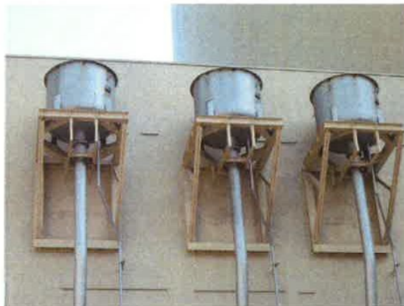
図3 主蒸気逃がし弁消音器の設置状況
