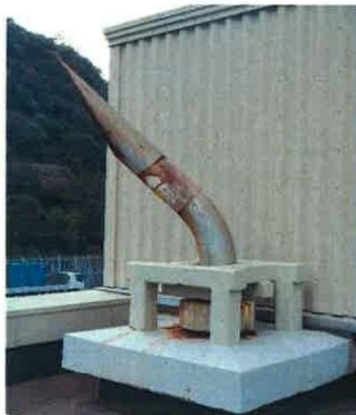
図 1 タービン動補助給水ポンプ蒸気大気放出管の設置状況
