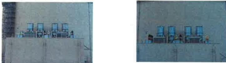
図 3 主蒸気逃がし弁消音器の設置状況 (左 3号炉、右 4号炉)
