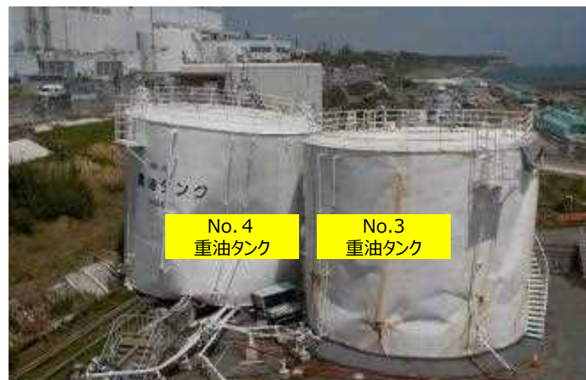
No.3,4重油タンク状況
