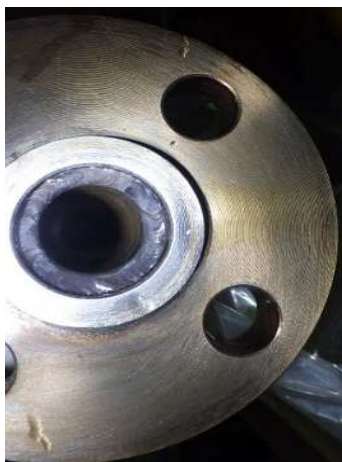
①入口配管
