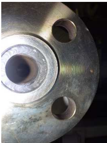
①入口配管
