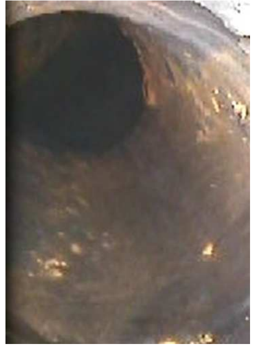
SGブローダウンタンク出口
