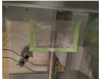
(フラッシングの様子)
