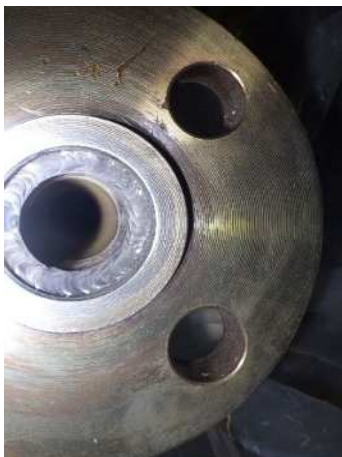
①入口配管
