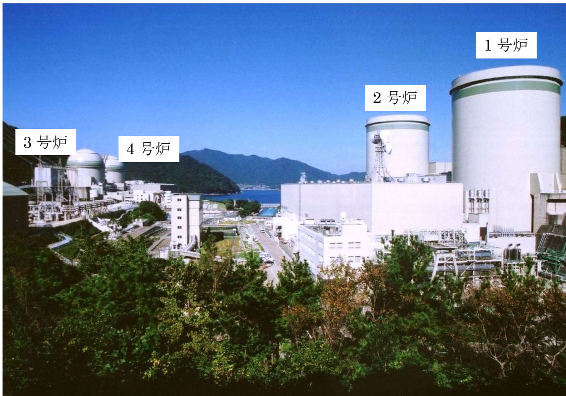
図-1-2-2 高浜発電所全景写真（1号炉側より）
