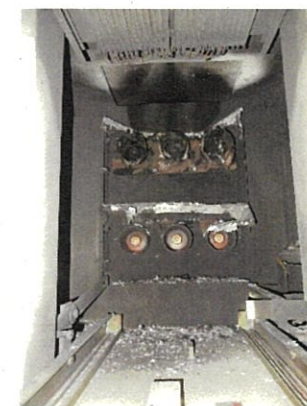
盤内開口部の状態(遮断器室)
