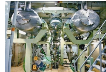
重水ポンプ室
