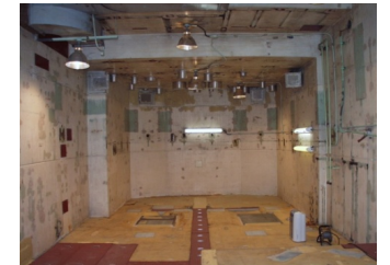
機器撤去後の重水ポンプ室
