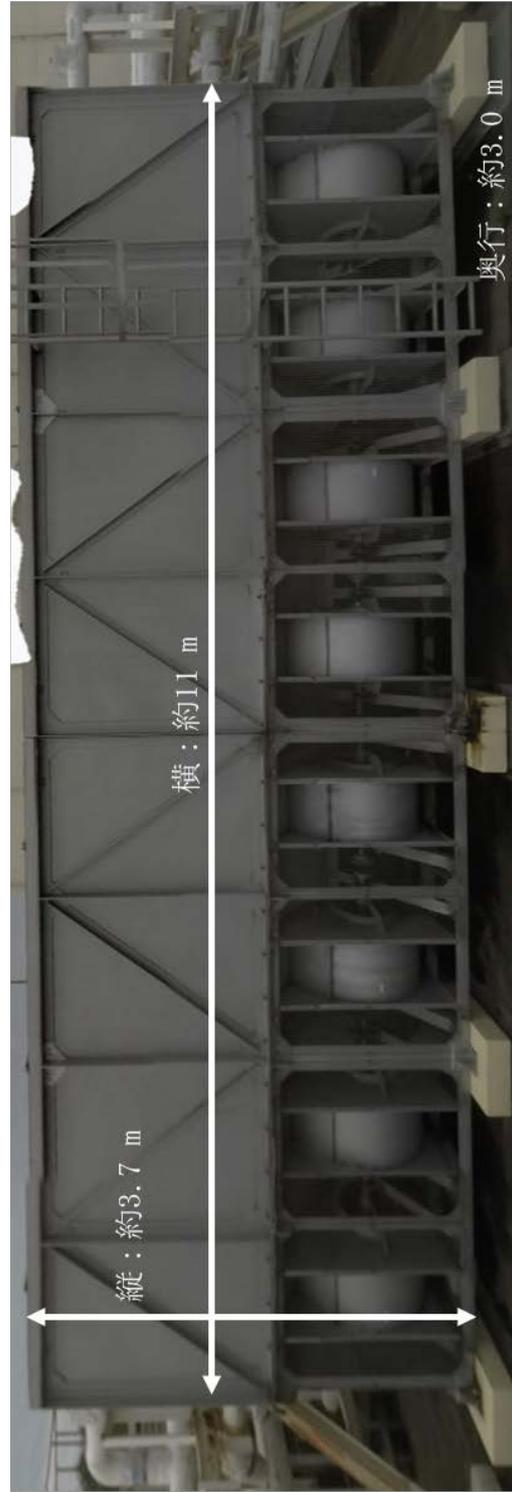
図-2.1 冷却塔概要（高放射性廃液貯蔵場（HAW））
