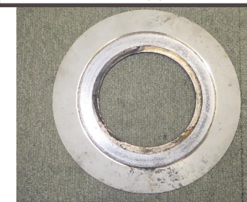
主給水制御弁バイパス管 フローノズル前管台フランジ
