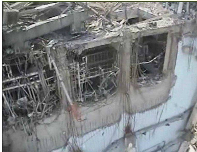
3号機原子炉建屋 西外壁
