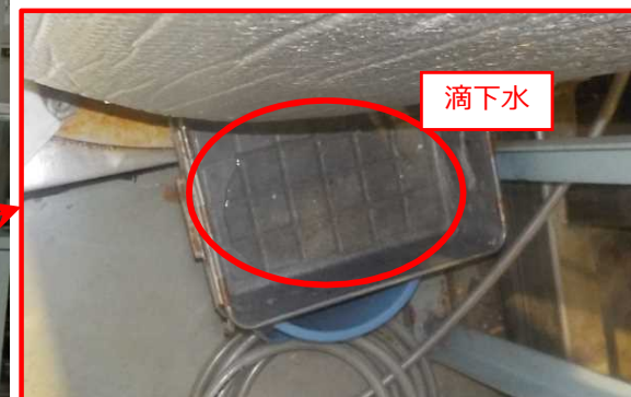
現場状況（写真）
