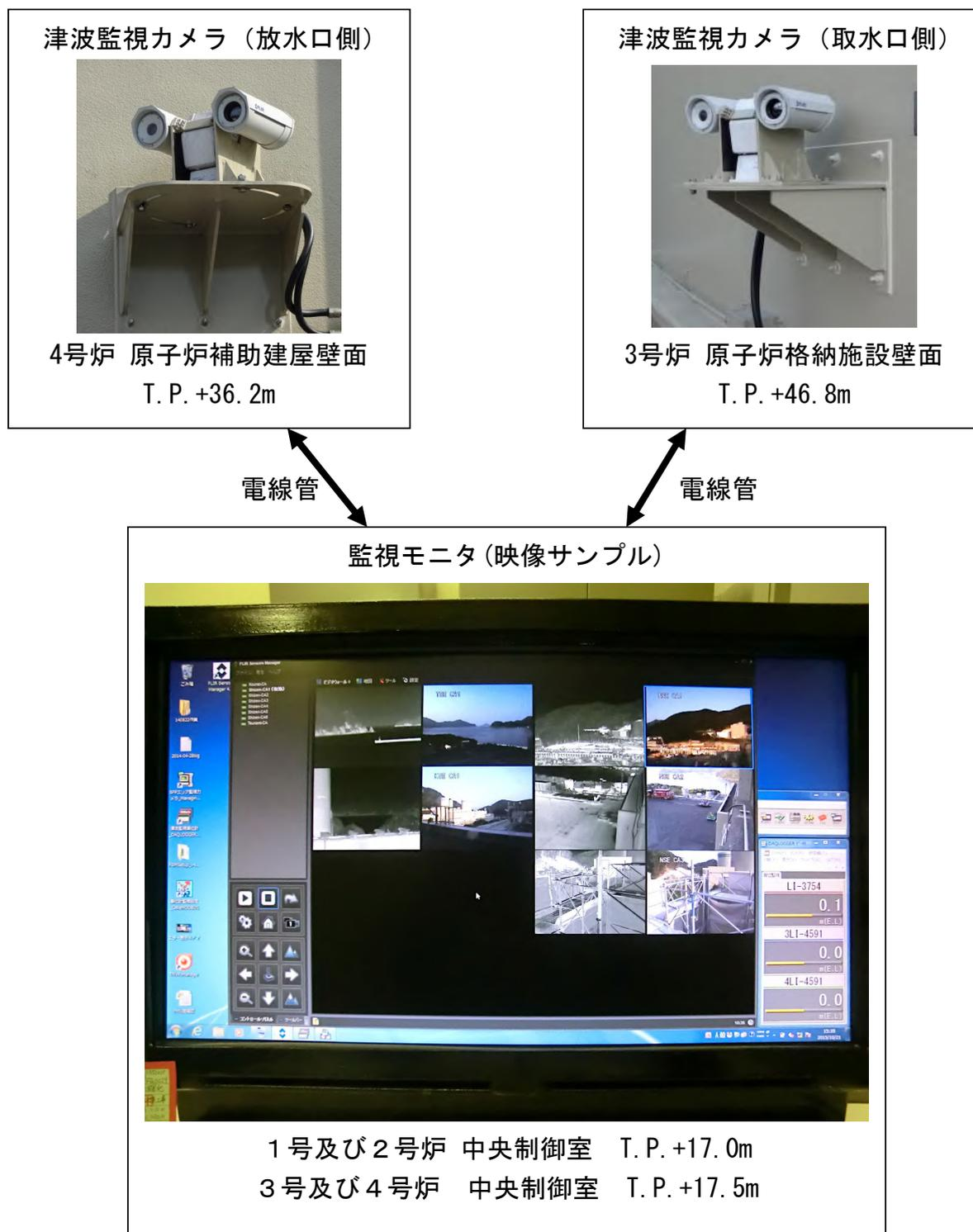
図 3-3-2 津波監視カメラ設備構成イメージ
