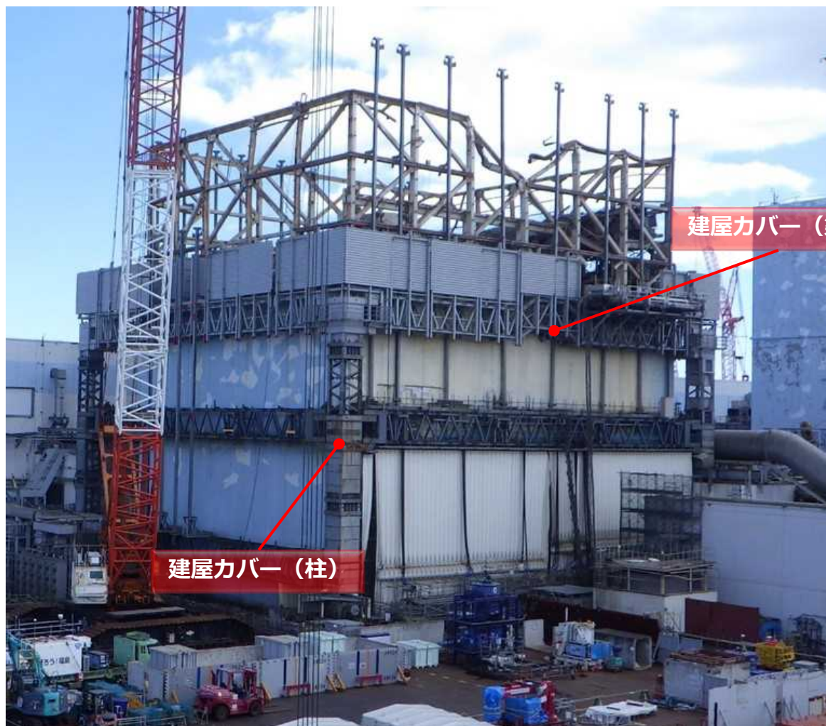
建屋カバーの現状（撮影日：2020.3.15）
