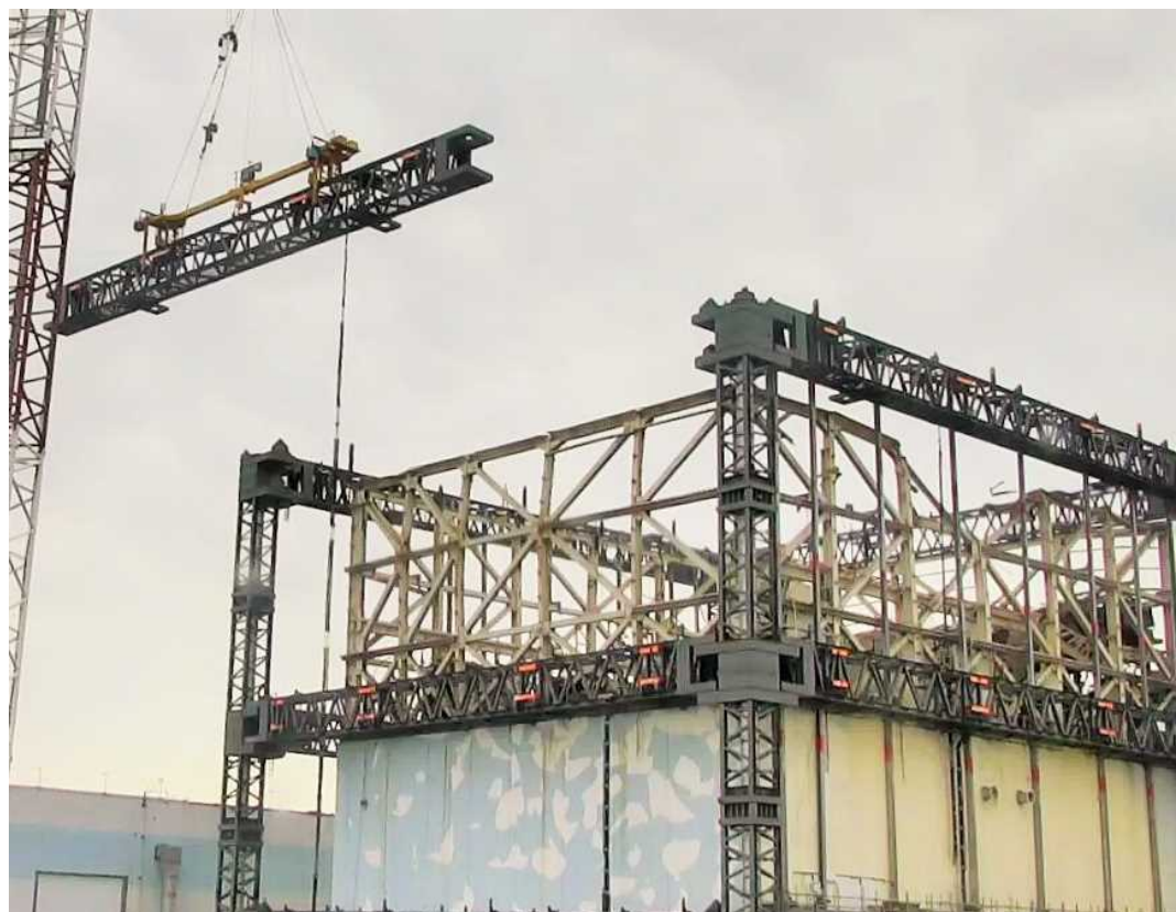
写真 建屋カバー解体状況（撮影日：2017.3.31）
