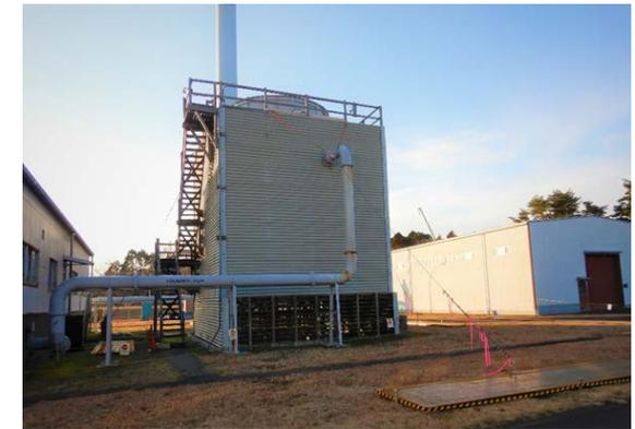
全体の交換・補修工事が完了していないため、4方向からのワイヤーロープによる固定は継続
