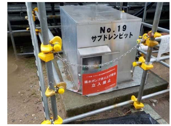
(サブドレンNo.19ピット)
