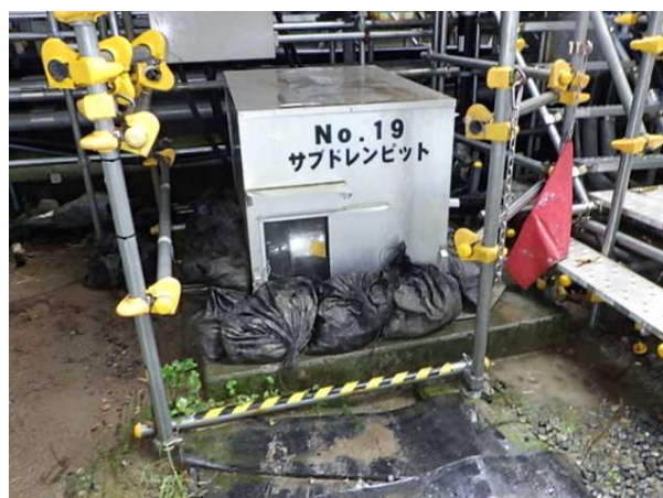
暫定対策後（7/14） （サブドレンNo.19ピット）
