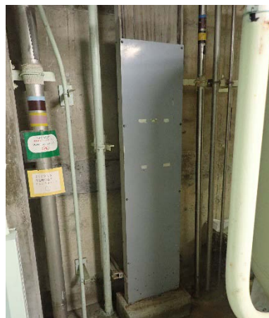
77. ケーブルダクト
