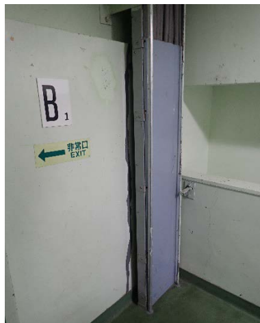
31. ケーブルダクト
