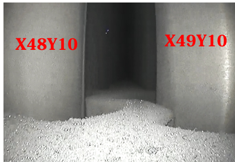
第三管支持板上写真
