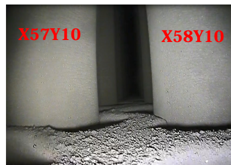
第五管支持板上写真
