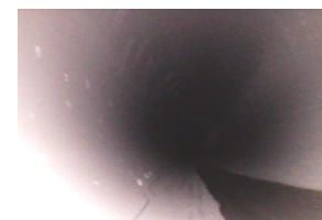
格納容器出口付近
