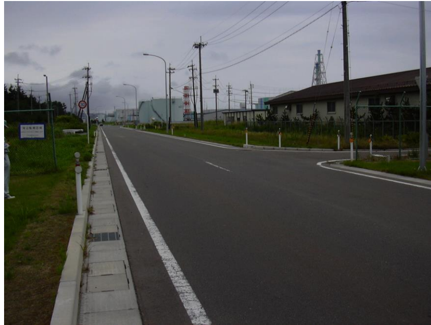
環境管理センター側との出入り部（A1部） （奥が再処理施設側）
