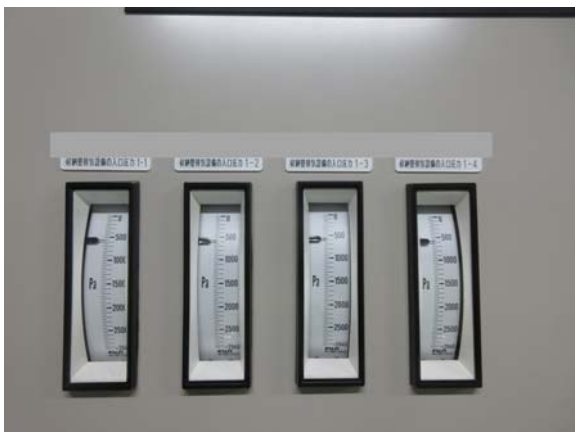
現場監視制御盤（圧力測定用）
