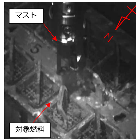
マストと配管の干渉により 吊ることができない燃料 (No.14)
