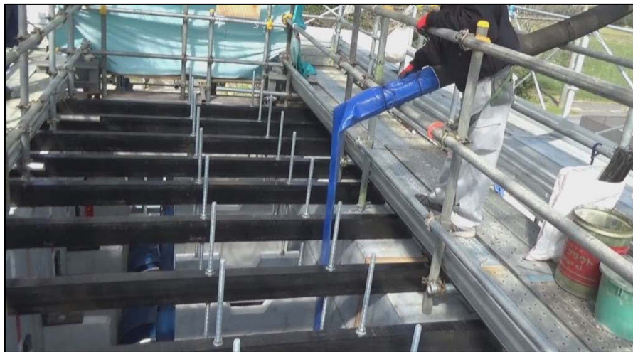
第 25 図 充填モルタル打込み状況
