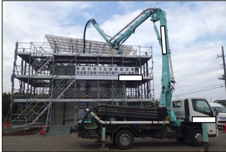
第 23 図 モルタル打設方法
