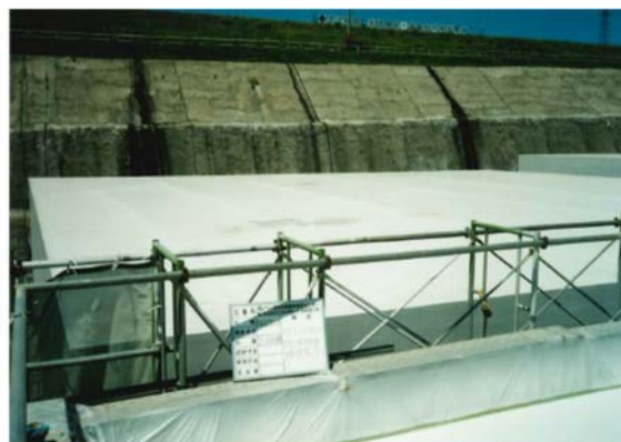
仕上げ材吹付け
