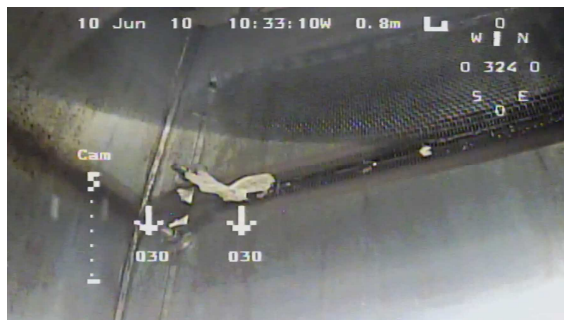
スキマサージタンク入口（北西側）正面の様子
