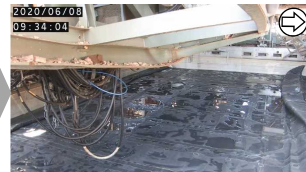
養生バッグ展張 (撮影日: 2020.6.8)
