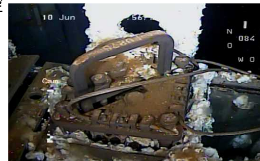
ワイヤー修復燃料上部の様子
