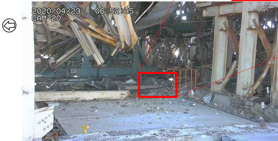
支障ガレキ撤去範囲 (撮影日: 2020.4.23)
