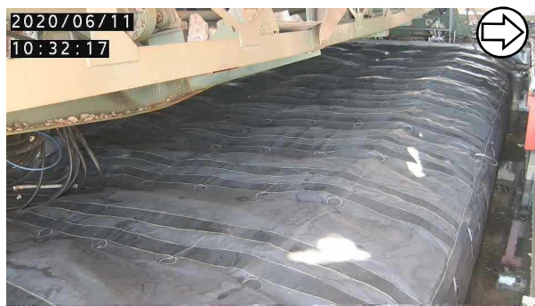
エアモルタル充填 (撮影日: 2020.6.11)
