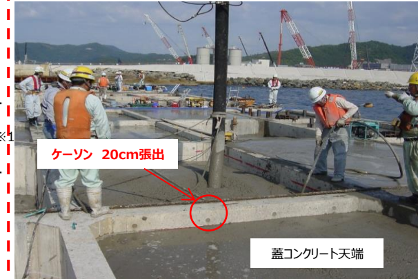
蓋コンクリート打設状況
