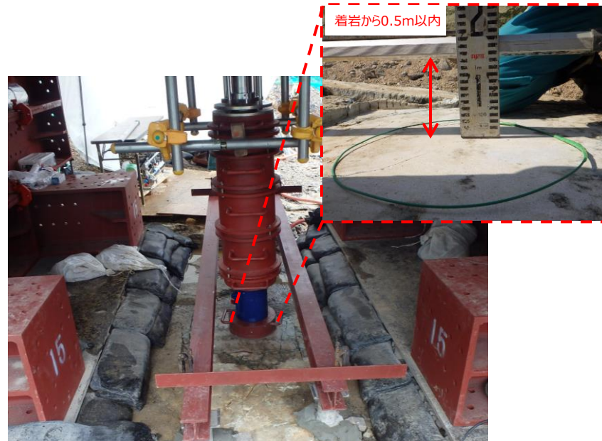
試験状況（全景）
