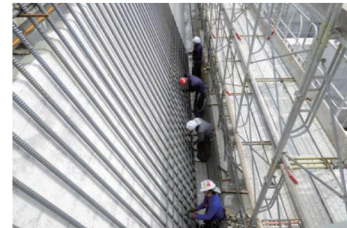
陸側鉄筋組立状況
