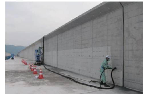
目荒らし施工状況
