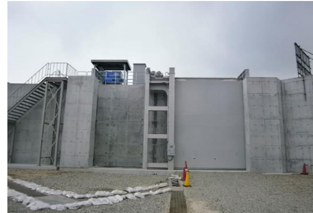
④防波壁通路防波扉（1，2号炉北側） 設置状況
