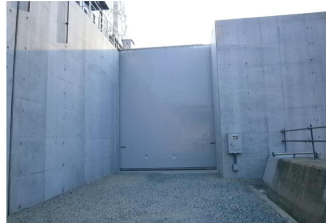
③防波壁通路防波扉（1，2号炉北側） 設置状況
