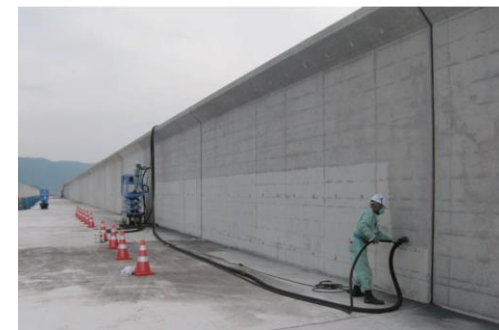
目荒らし施工状況
