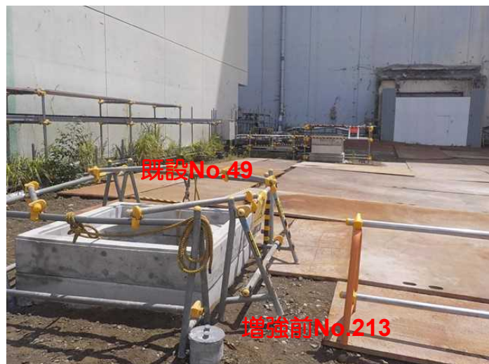
No.49ピット周辺
