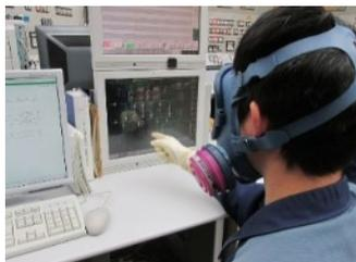
予備変圧器 2 次側恒設ケーブルを使用した号機間融通受電準備操作
