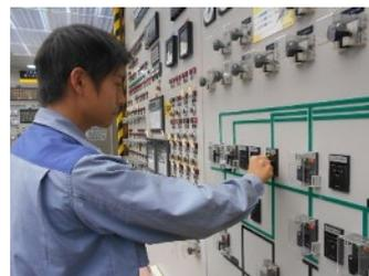
予備変圧器 2 次側恒設ケーブルを使用した号機間融通による遮断器投入操作
