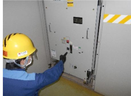
号機間電力融通恒設ケーブル（1，2号～3号）を使用した号機間融通による交流電源給電遮断器操作（3号炉スイッチギヤ室）
