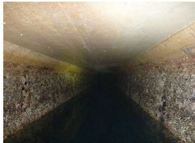
図-1-4-9 1号炉及び2号炉放水路内の状況
