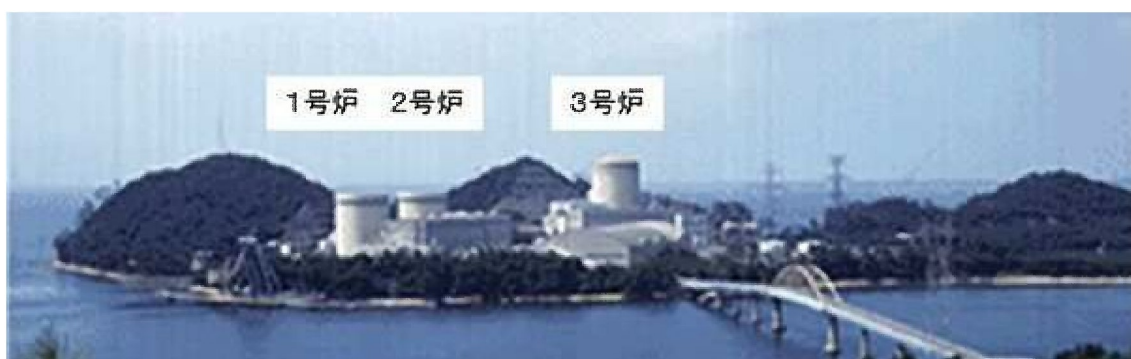
図-1-2-2 美浜発電所全景写真
