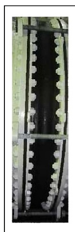
図-2-4-5 循環水管の伸縮継手部
