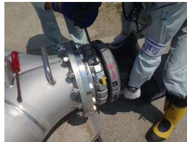
二口分岐接続 (300A×300A×2口)
