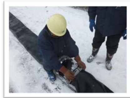
建屋外ホース接続 (300A)
