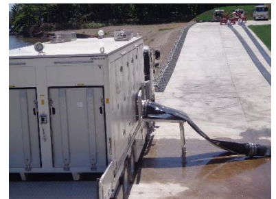
可搬型建屋外ホース接続 (300A)
