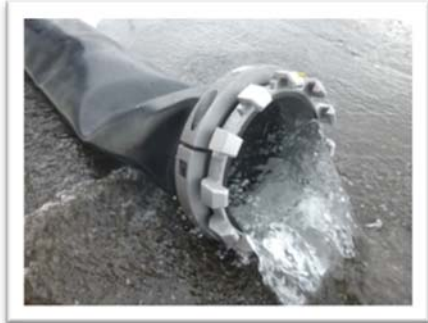
建屋外ホース接続箇所 (300A)
