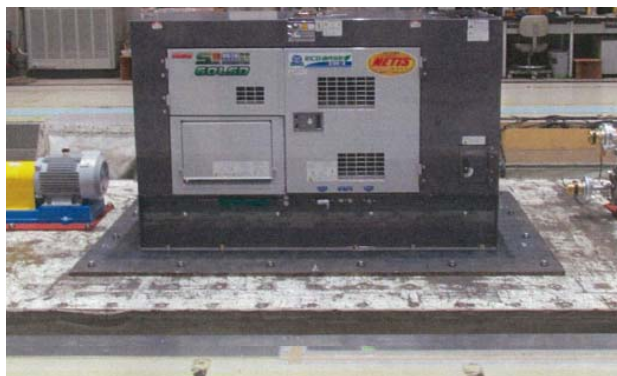
可搬型発電機
