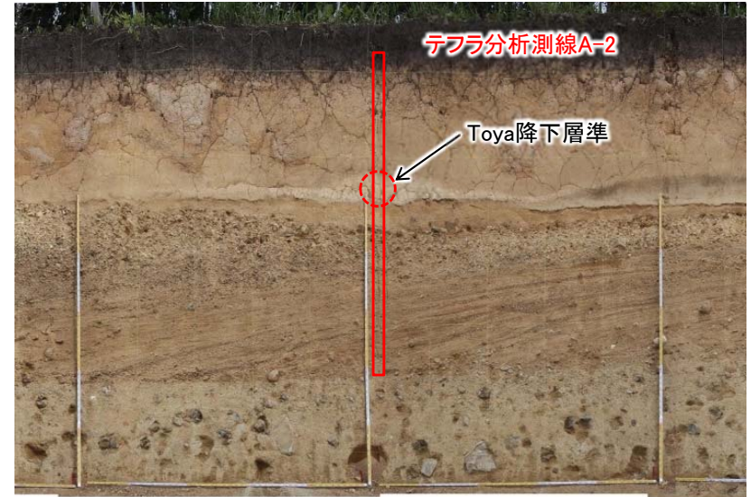
法面④詳細画像
