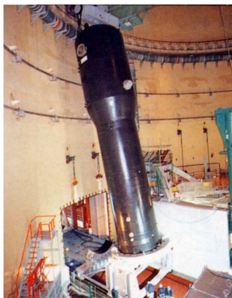
図 3.1.1-5 大型機器の取替作業の例（左：蒸気発生器、右：高圧給水加熱器）
