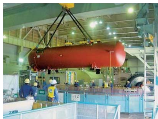
図 3.1.1-4 大型機器の取替等の実績（BWR の例） [1]
