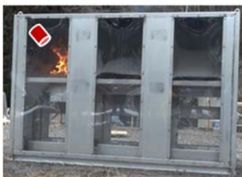
火災源直上から約400mmに設置
