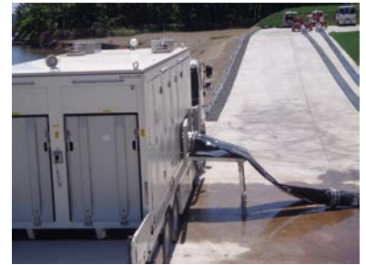
可搬型建屋外ホース接続 (300A)
