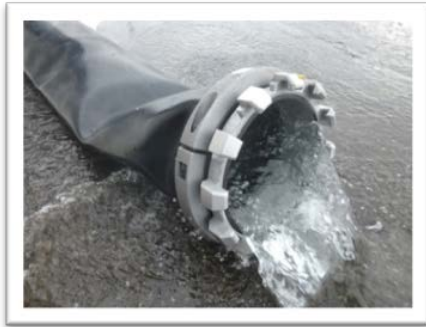
建屋外ホース接続箇所 (300A)
