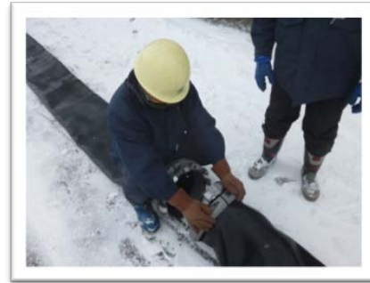
建屋外ホース接続 (300A)
