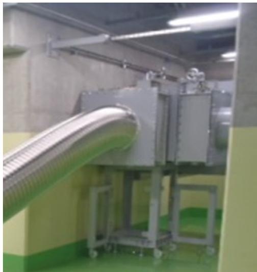
(可搬型設備と常設設備はフランジにより接続)
