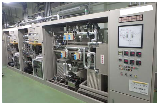
第 1.2.2 図 排気モニタリング設備の外観
