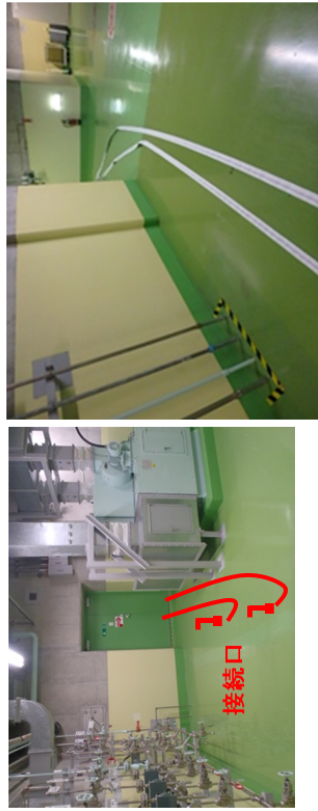
第 2. - 28 図 精製建屋の精製建屋のセルへの導出経路の構築及び代替セル排気系による対応概要 (その 1)
