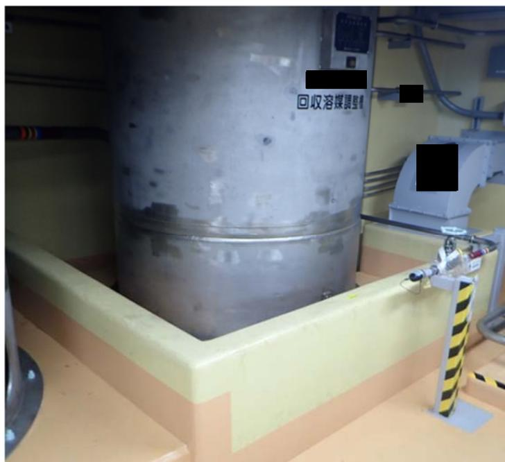
第3図 堰による拡大防止対策例
