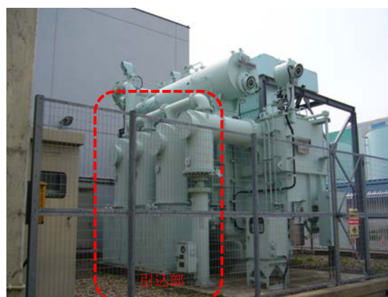
受電変圧器（露出部無し）
