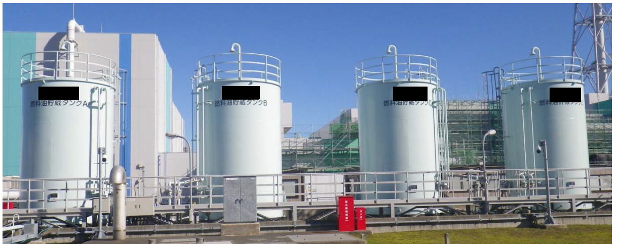
8. G 7 ディーゼル発電機設備用燃料油受入れ・貯蔵所 ： 燃料油貯槽タンク A / B / C / D [ ██████████ ]
