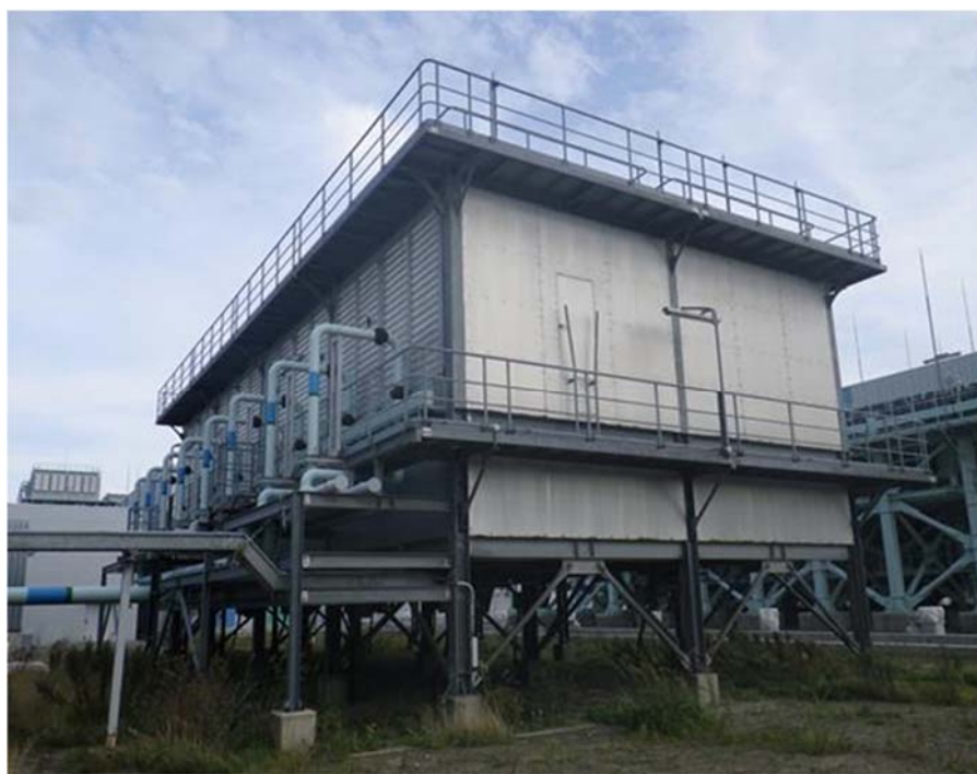
10. G 9 運転予備用冷却水設備：冷却塔 [ ]
