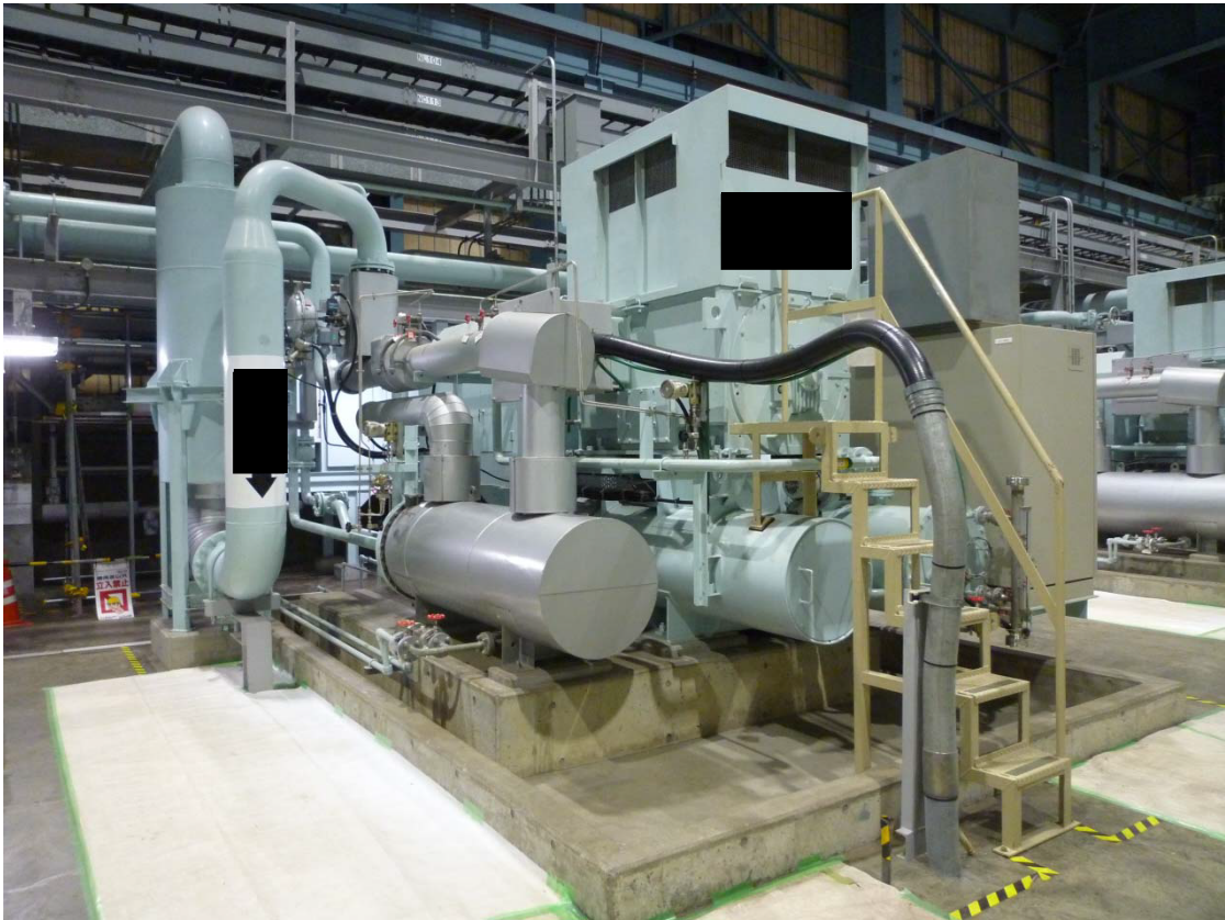
写真：空気式緊急遮断弁の駆動源となる空気圧縮機
