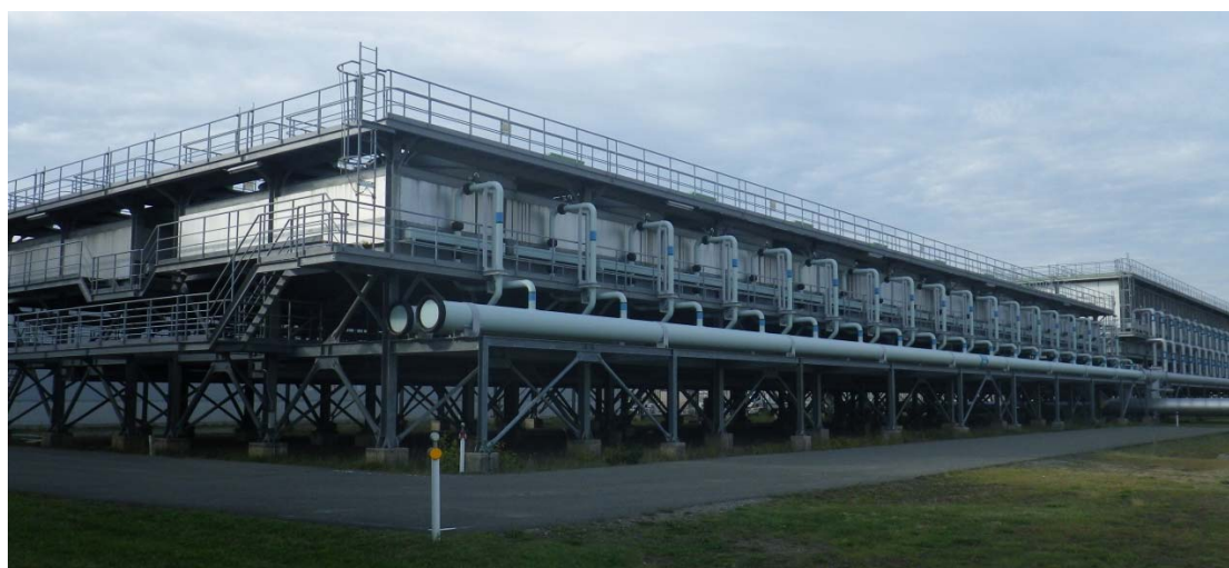
2. G 2 常用冷却水設備：冷却塔 [ ██████████ ]
