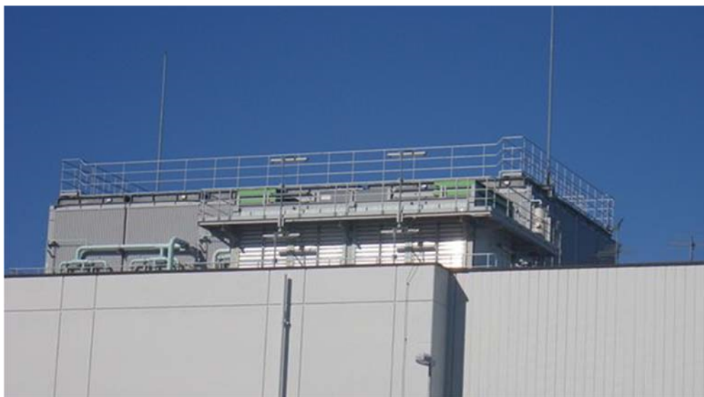
9. G 8 先行 常用冷却水製造設備 ： 冷却塔 [ ]、膨張槽 [ ]
