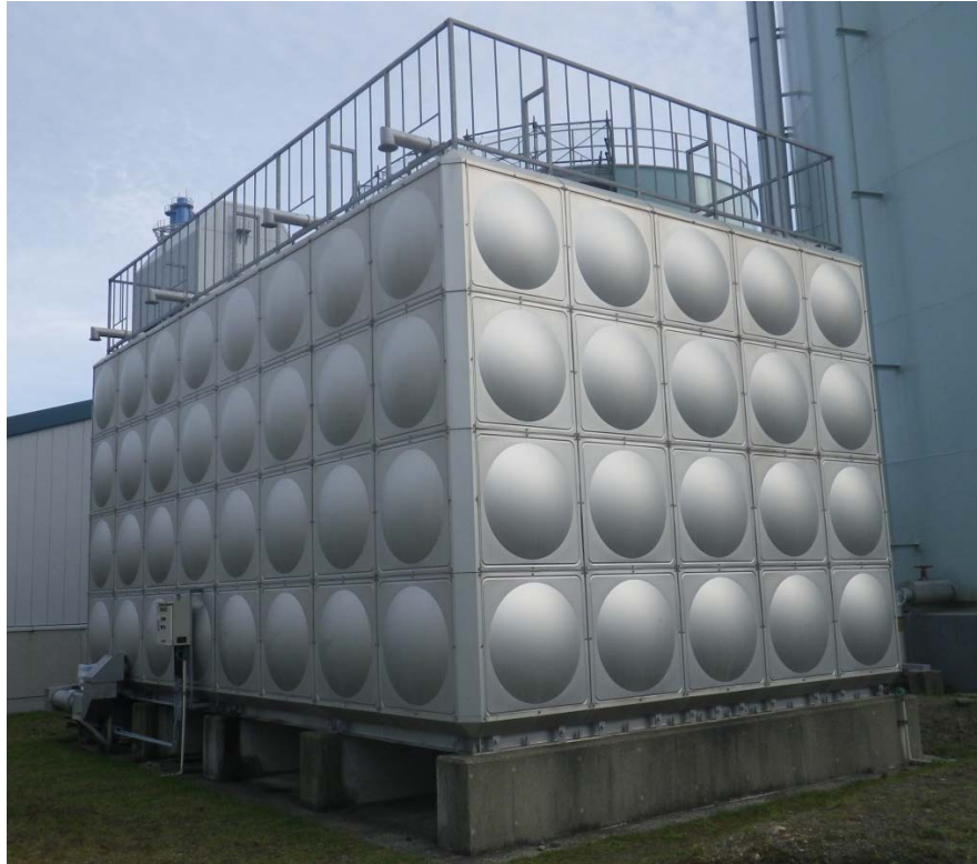
7. G 6 工業用水施設：飲料水増設貯槽 [ ██████████ ]
