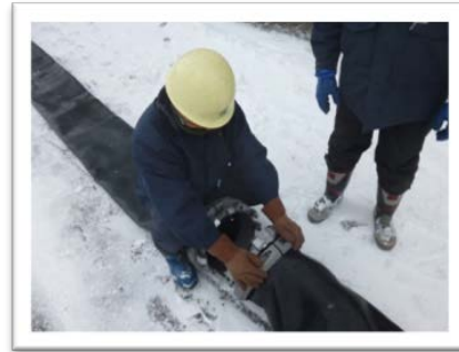
建屋外ホース接続 (300A)
