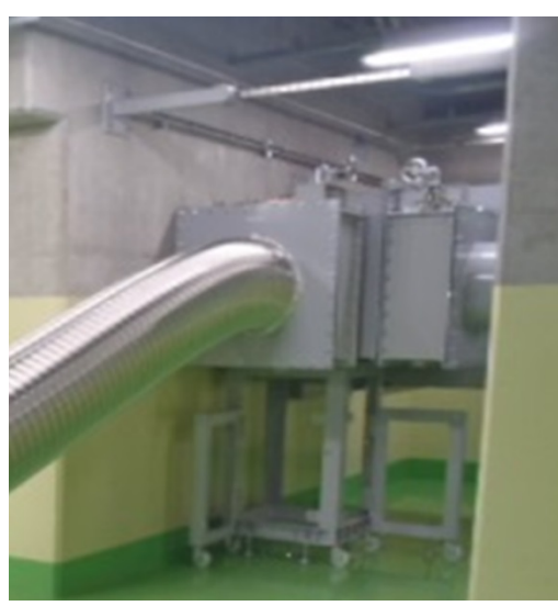
(可搬型設備と常設設備はフランジにより接続している)
