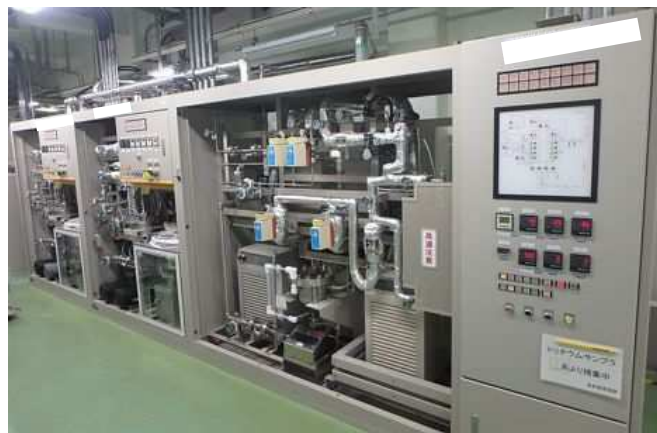
第 1.2.2 図 排気モニタリング設備の外観
