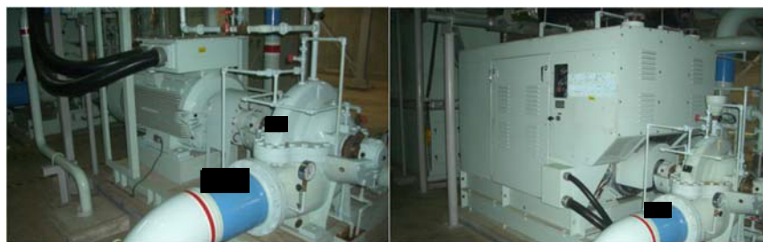
電動機駆動消火ポンプ
