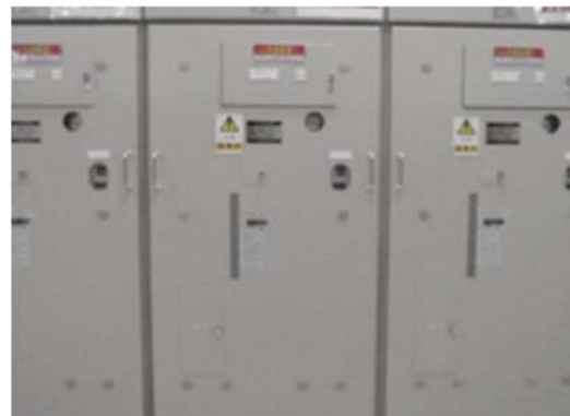
第7図 ガス遮断器
