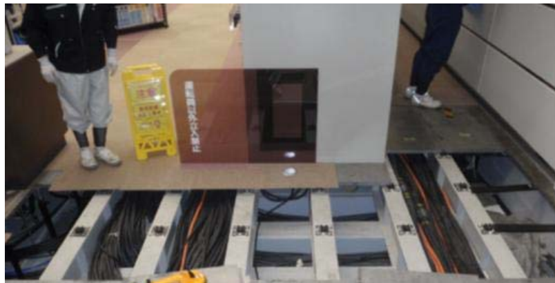
ケーブル敷設状況
