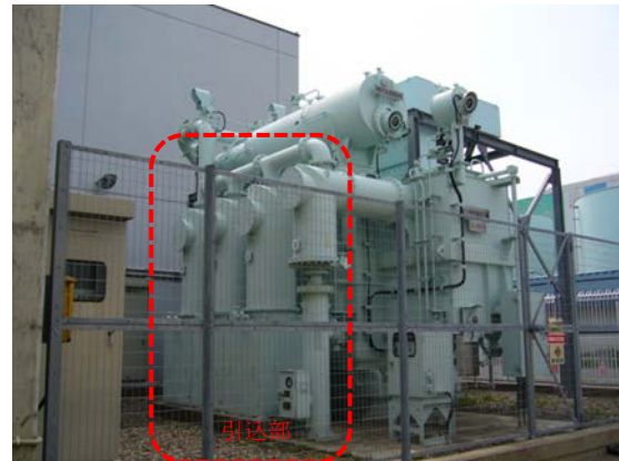
受電変圧器（露出部無し）
