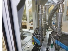
接続口 40A配管
