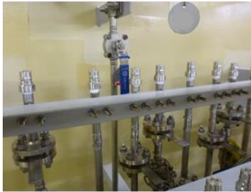
接続口 20A配管
