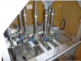
接続口 25A配管
