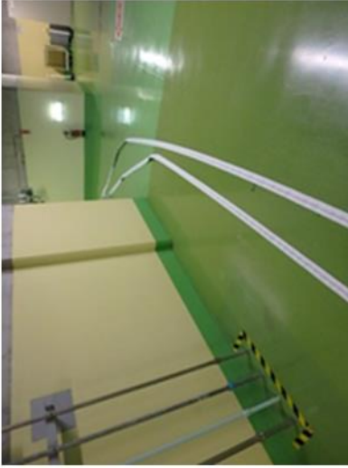
第 2. - 28 図 精製建屋の精製建屋のセルへの導出経路の構築及び代替セル排気系による対応概要 (その 1)
