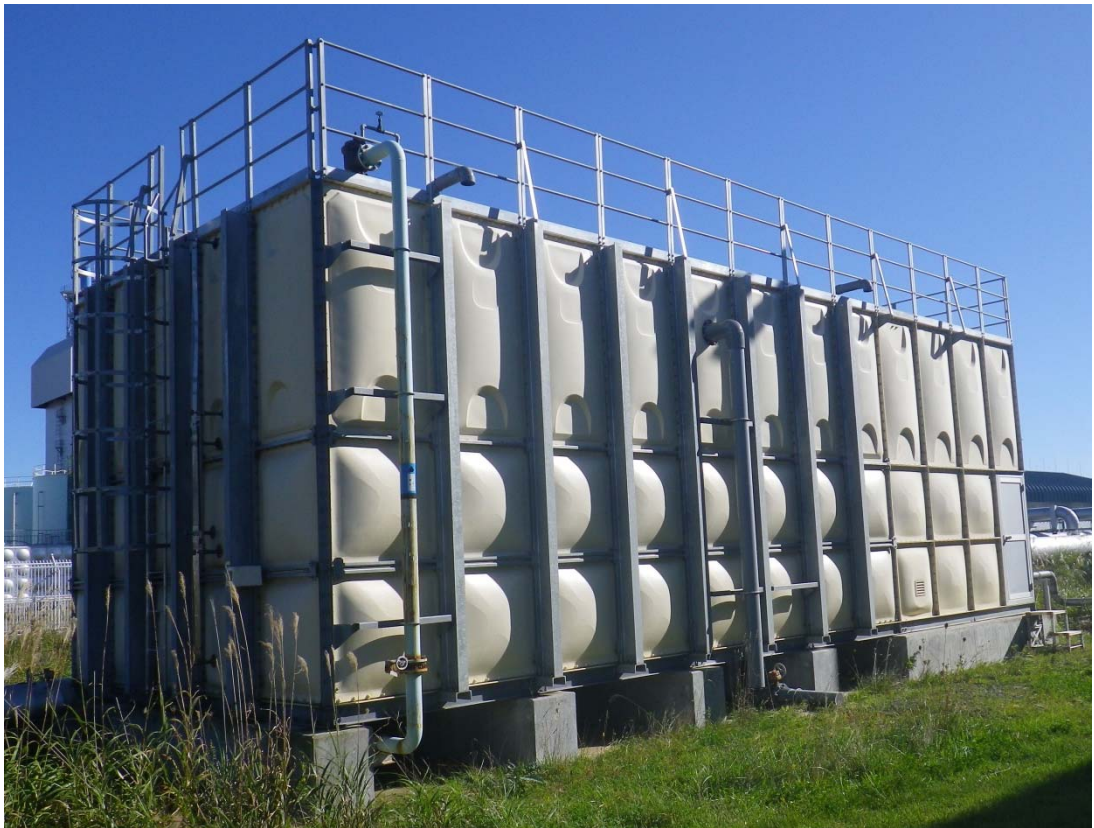
3. G 2 常用冷却水設備：散水用水貯槽 [■■■■■]
