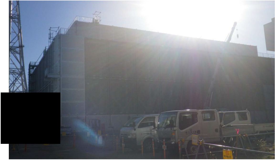
19. 使用済燃料受入れ・貯蔵施設用冷却水設備： 安全冷却水系冷却塔A／膨張槽A [ ]
