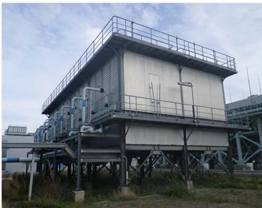
10. G 9 運転予備用冷却水設備：冷却塔 [ ]
