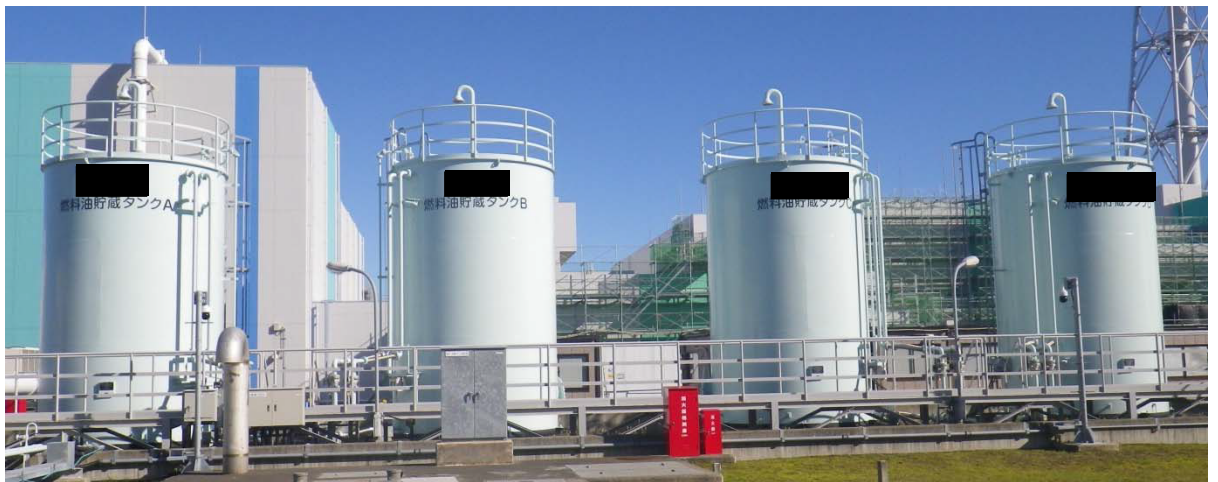
8. G 7 ディーゼル発電機設備用燃料油受入れ・貯蔵所 ： 燃料油貯蔵タンク A / B / C / D [ ██████████ ]
