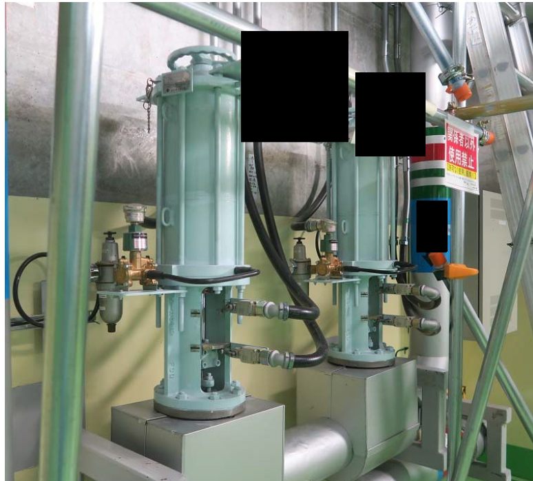
第3図 現場写真 [■■■■■]
