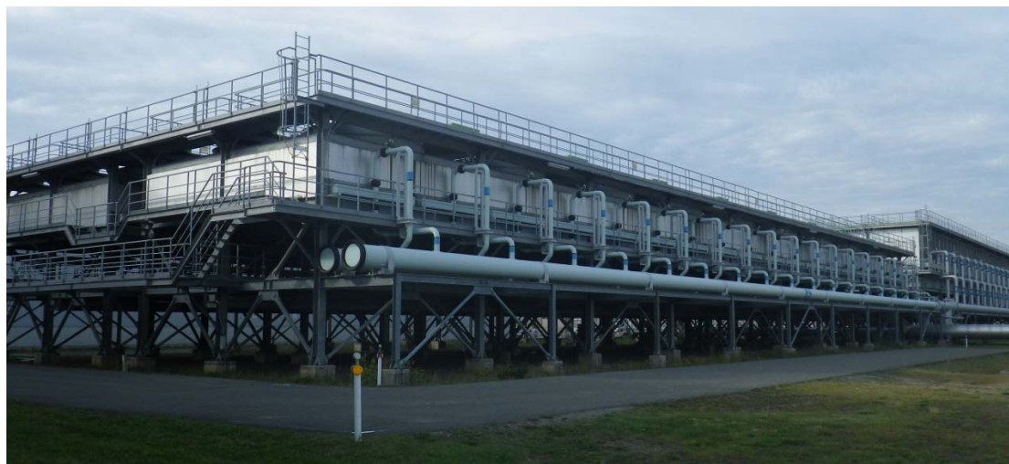
2. G 2 常用冷却水設備：冷却塔 [■■■■■]
