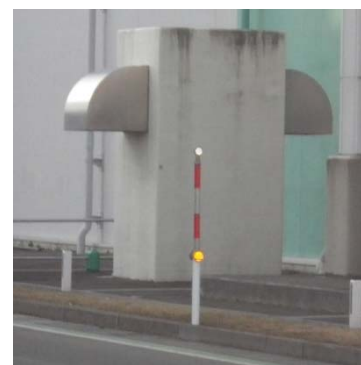
洞道の排気口
