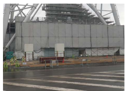
③ 試薬建屋入口から北側を撮影
