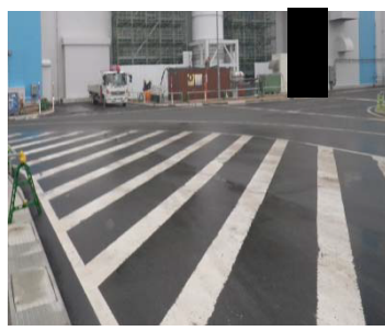
② 試薬建屋入口から西側を撮影
