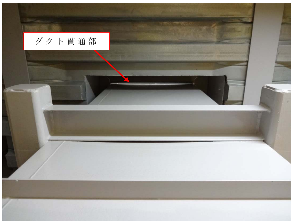
第 2 図 天井面の貫通部（例）
