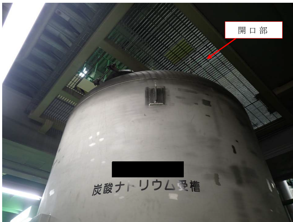
第 1 図 天井面の開口部（例）
